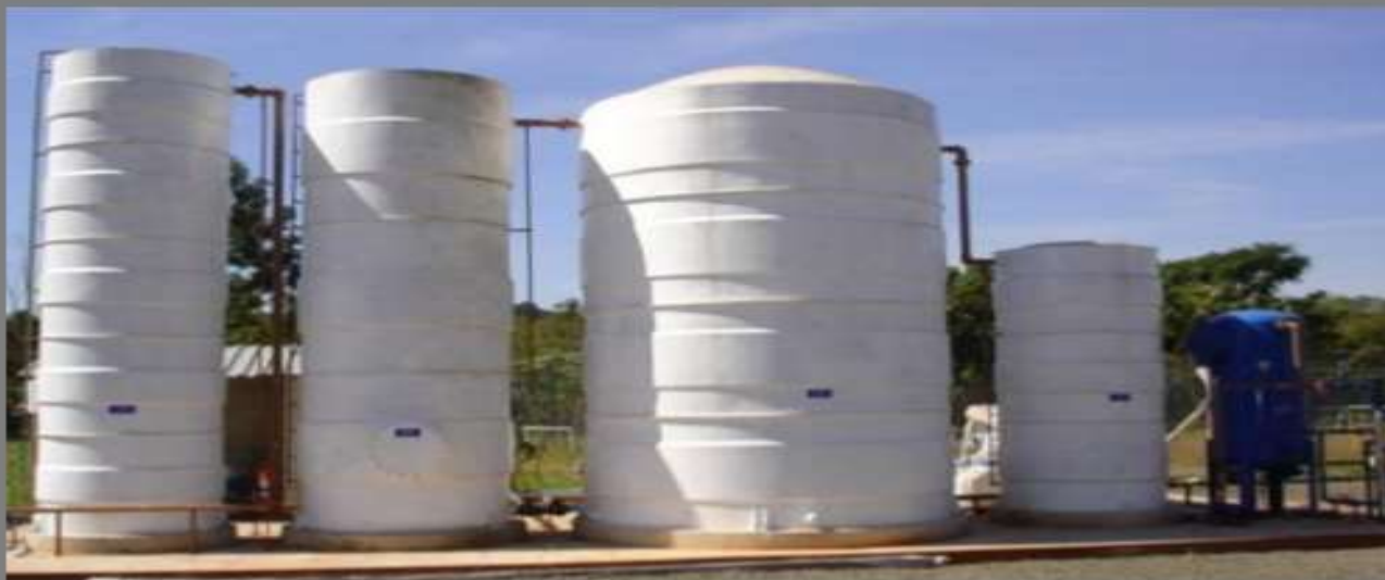
Estação de Tratamento de Efluentes proveniente dos laboratórios e das salas de exames.
